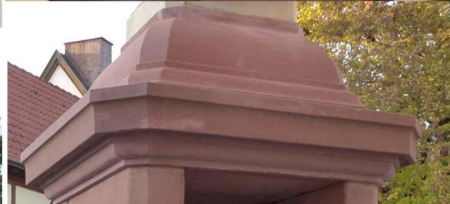
Fugen am allen Sandsteinteilen mit Kalkzementmörtel saniert.
