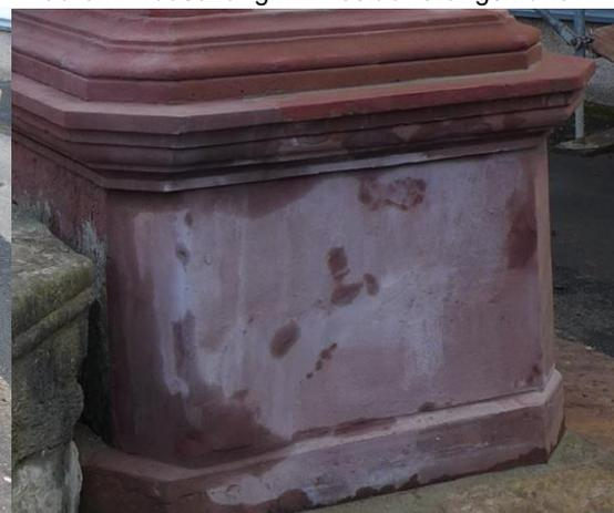
Der Sandsteinsockel vermutlich Neuteile von 1982 wurde mit Essigessenz gewaschen. Nach ein paar Tagen wird der rote Sandstein wieder mit Kalk weislich. Maßnahme: Opferschicht aus einem feinen roten Mineros 2000 Auftrag. Der aufschaltende rote Sandstein wurde mit Mineros 2000 an gebösch.
