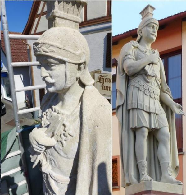
Ausbesserung an der Figur an der Standfläche mit Kalksteinersatz.
