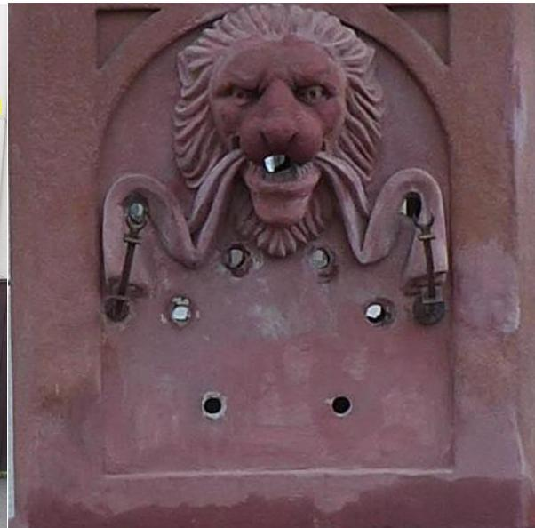
In Mittelteil des Brunnenstocks vorne Löwen Kopf wurden die auf Schälungen an gebösch. Da der Frontbereich nur durch an Böschung nicht ansehnlich wirkt, wurden die Fehlstellen mit Mineros auf den Originalsten aufgebaut, ohne Substanzverlust. Dies dient zur Akzeptanz, da die Frontplatte wesentliches Bildnis des Sebastianbrunnens ist.
