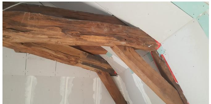
Fachgerechte Instandsetzung des Dachwerks, der hölzernen Deckenkonstruktionen und der Fachwerkwände. Ertüchtigung und Austausch von Fachwerkwänden, Sanierung und statische Verstärkung der Deckenkonstruktionen.
