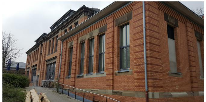
Die Firma Schorn hat die Fassade substanzschonend gereinigt, Fugen erneuert und beschädigte Ziegel und Natursteine ausgetauscht. Größere Schäden in der Fassade wurden behoben und spätere bauliche Veränderungen denkmalgerecht sorgfältig zurückgebaut.
