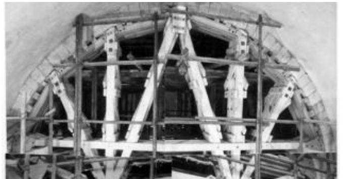
Wiederaufbau nach schwerer Kriegszerstörung. Statische Sicherung der erhaltenen Bausubstanz nach Ausbau der Nachkriegsprovisorien. Aufwändige Auswechslung des Trompenmauerwerks der Vierung.
