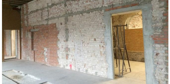
Zur Ertüchtigung des Mauerwerks und der statischen Sicherung werden Einbauten früherer Maßnahmen rückgebaut. Unter Berücksichtigung der historischen Substanz wird aufgemauert, neue Fenster- und Türöffnungen eingefügt sowie ein Aufzugsschacht eingebaut.
