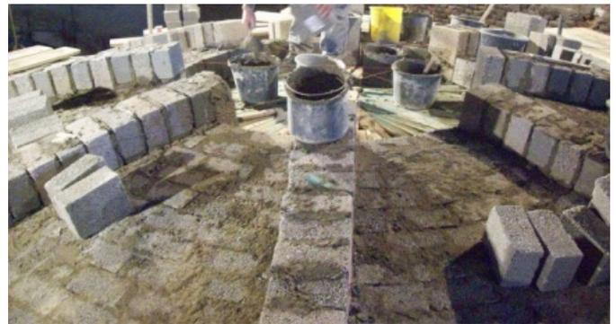
Einrüstung der statisch gefährdeten Mittelschiffgewölbe und abschnittsweiser Abbruch. Erneuerung der Gurtbögen, Leererüstbau und Einwölbung der Bimskuppeln.
