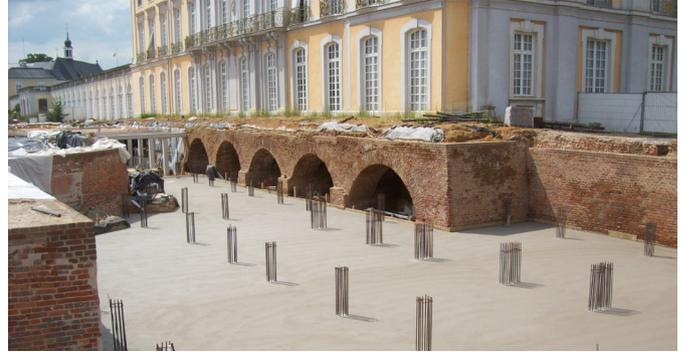
Grundsanierung der vorgelagerten Terrassenkonstruktion der Schlossanlage auf der Parkseite.
