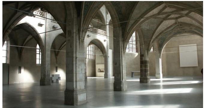
Rückführung auf romanische und gotische Bausubstanz verbunden mit einer modernen Raumfassung. Statische Sicherung durch Auswechslung tragender Säulenelemente. Überarbeitung und Neugestaltung der Werksteinausstattung.
