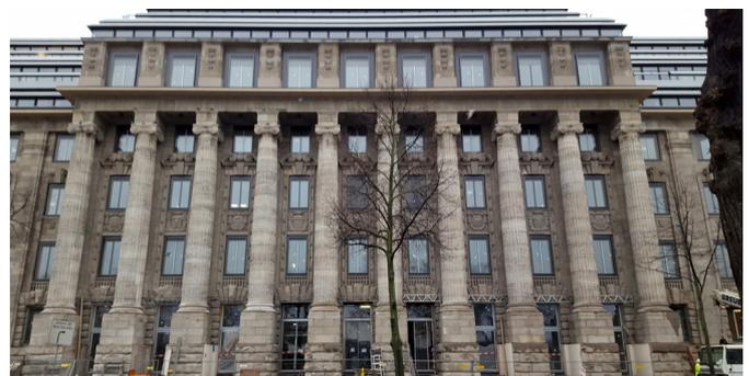
Die Firma Schorn hat das Mauerwerk mit HDS-Heißdampfreiniger und im Niederdruckrotationsverfahren gereinigt. Schadhafte Stellen im Mauerwerk und an den Säulen haben wir ausgetauscht sowie durch Vierungen oder Restauriermörtel ergänzt. Putzflächen an den Laibungen wurden zurückgestemmt und neu verputzt. Die Betondecke des Dachaufbaus wurde mit Natursteinplatten verkleidet.
