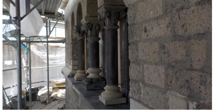
Die Mauerwerkssanierung von St. Severin durch die Firma Schorn umfasste u.a. die substanzschonende Erneuerung der Natursteinfassade. Dabei wurden Vierungen aller Art, Restauriermörtelergänzungen sowie ganze Bauelemente wie etwa Säulenbasen hergestellt.
