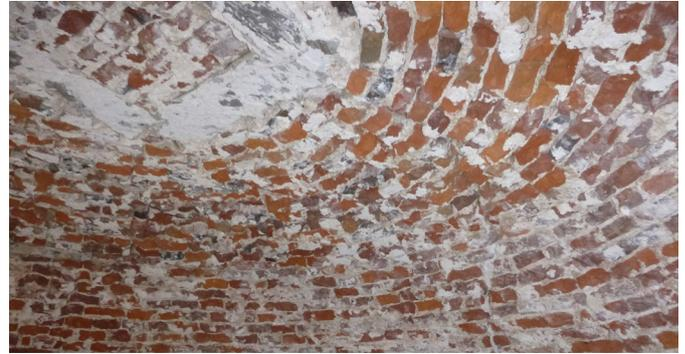
Manuelle Auslösung loser Ziegelsteine und anhaftenden Restputzes im stark beschädigten Gewölbe, an Wänden und Hohlstellen. Abschnittsweise Ergänzung der größeren Fehlstellen mit geeigneten Ziegelsteinen, Auffüllung kleinerer Fehlstellen mit Putzmörtel.
