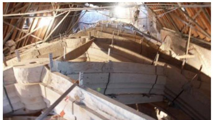
Ausbau und Wiederherstellung der gesamten Einwölbung. Anfertigung der Tuffsteinrippen und Schlusssteine in eigener Werkstatt. Leererüstbau und Einwölbung mit Bimsstein. Einzug von Edelstahlankern.
