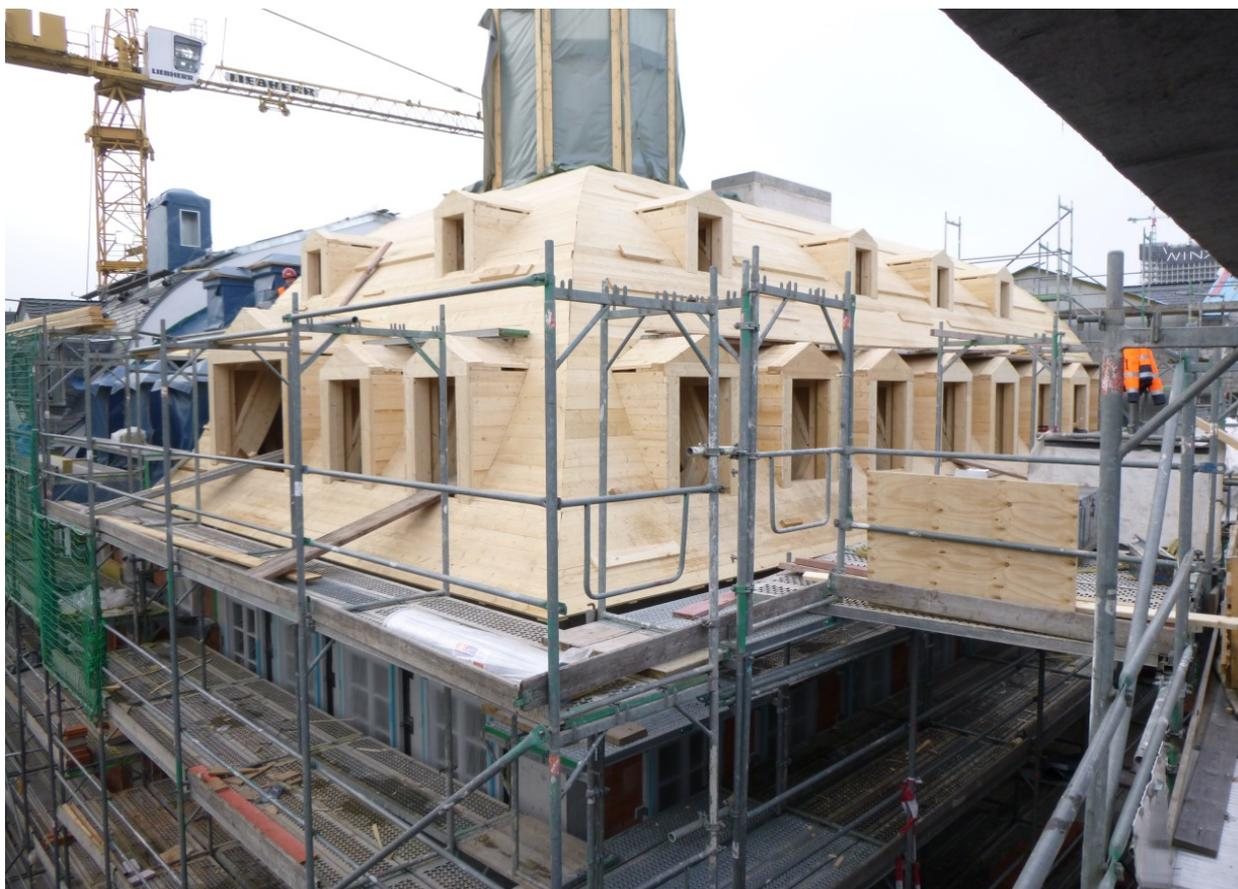
Leistungen : - Rekonstruktion von drei Dachstühlen nach historischem Vorbild mit gebogenen Brettschichtholzträgern der Firma Jagram GL24 / GL 28 :
