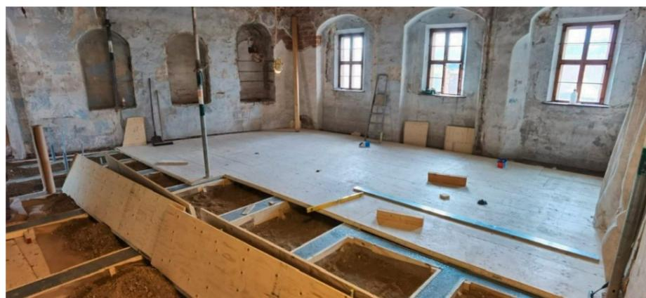
*Aufbringen und Verkleben der Furnierschichtholzplatten mit den verstärkten Deckenbalken zur Erhöhung der Trag-fähigkeit und Deckensteifigkeit*
