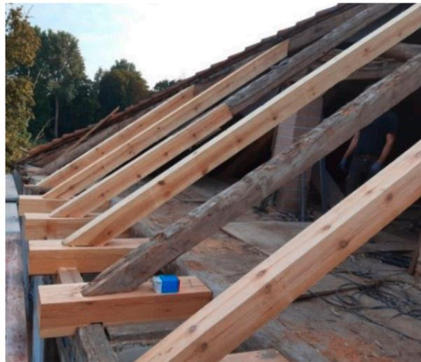
Nach dem Stellen des Baugerüsts wurde mit dem Rückbau der Dachhaut an den Traufen begonnen. Zum Schutz der geöffneten Flächen stellten wir zusätzlich ein Notdach auf. Während der partiellen Entschuttung und Entrümpelung der Traufen konnten die Mauerkrone und alle vorher nicht sichtbaren Holzbauteile näher begutachtet werden.
