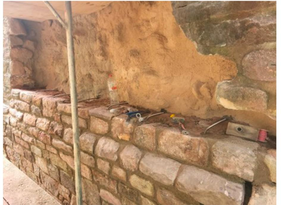
Neuer Mauerfuß mit Vernadelungen und darüberliegender Spritzmörtelsicherung der rückwärtigen ausbruchgefährdeten Mauerschale
