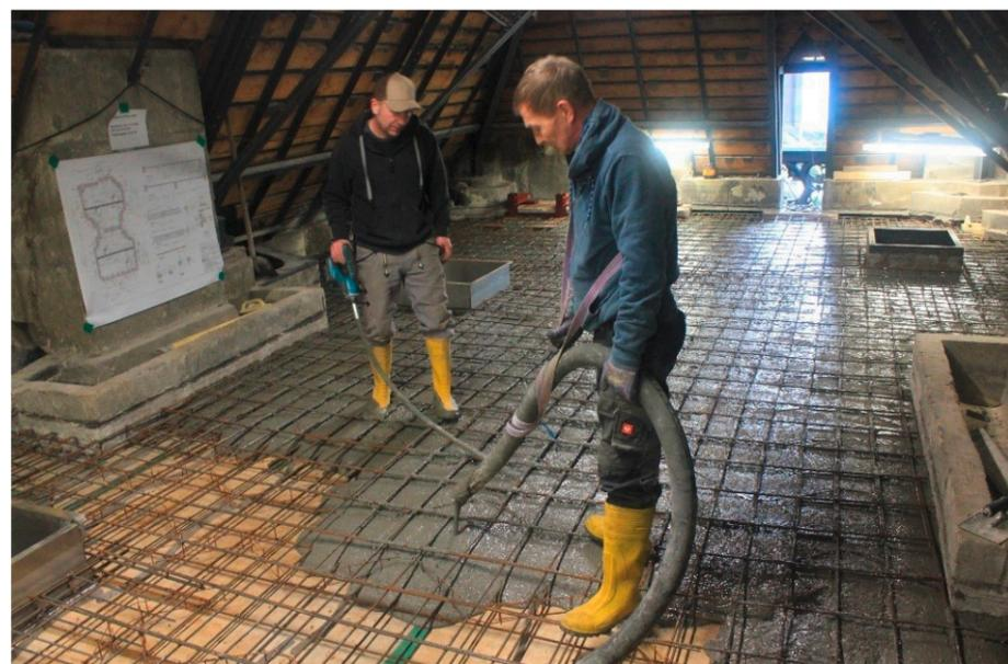
Betonage der neuen Schutzdecke über den Gewölben im Dachraum
