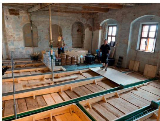
Zur Herstellung des Klebever-bundes zwischen COMPONO® und Holzbalken wurde der auf den Balken liegende Bohlenbelag minimal in Balkenmitte zurückge-schnitten. Anschließend wurde die Verschalung auf den Balken aufge-bracht und mit dem COMPONO® Polymerversguss verfüllt.
