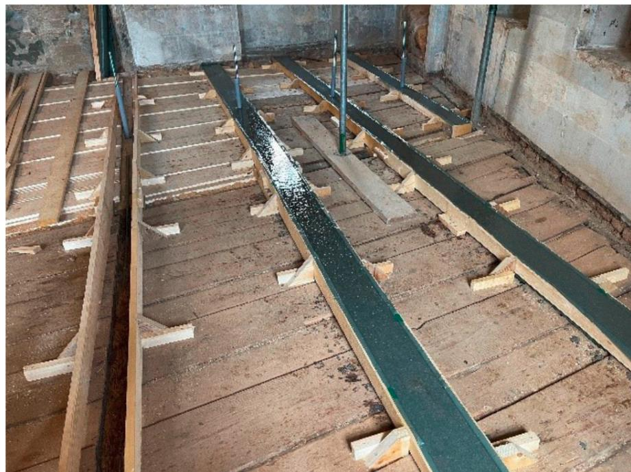
*Eingeschalte und frisch verstärkte Deckenbalken mittels COMPONO®*
