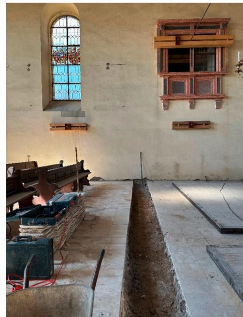
Graben für Zugankerherstellung nach Rückbau der vorhandenen Plattenbeläge
