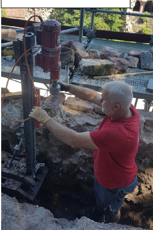
Ankerstäbe / Gewindestangen setzen und verpressen der Bohrlöcher
