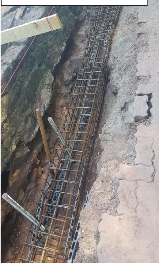
Abgetreptes betonieren des Streifenfundamentes
