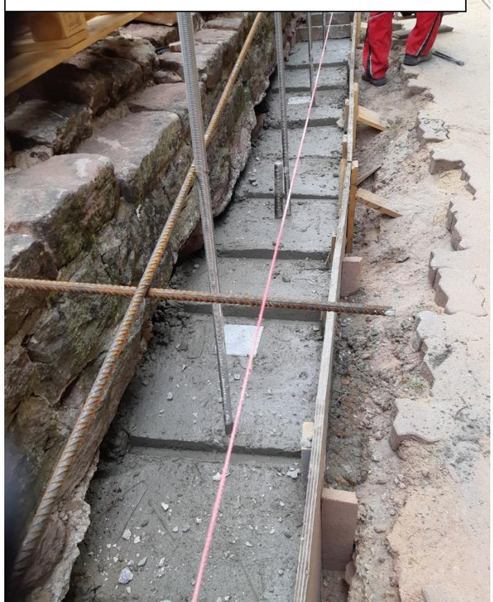
Auffüllen Arbeitsbereich hinter dem Streifenfundament mit Beton zur besseren Stabilisation
