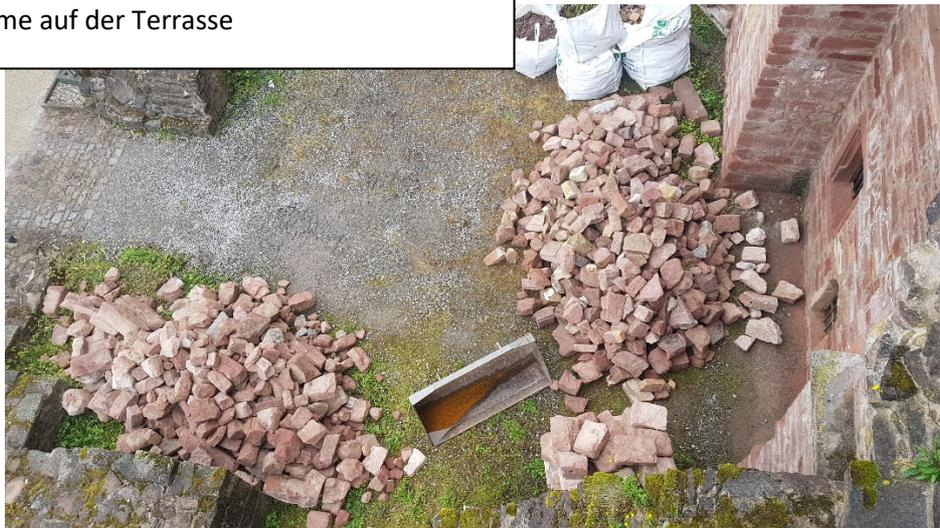
Beginn Rückbau des Pflasters und Grabenaushub
