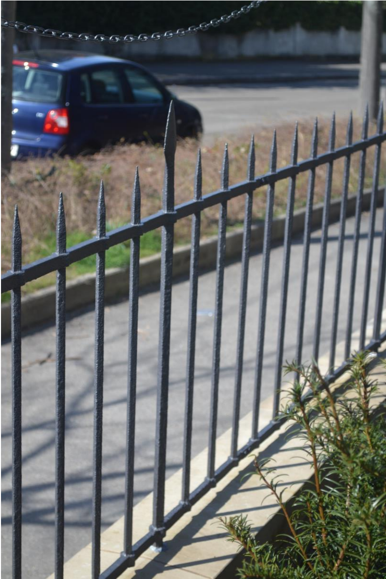
Restaurierung Zaunanlage und Tor Gänsheide 21 und A. Kröner-Str., Stuttgart
