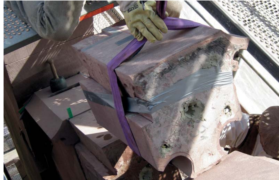
Reparatur durch Austausch
