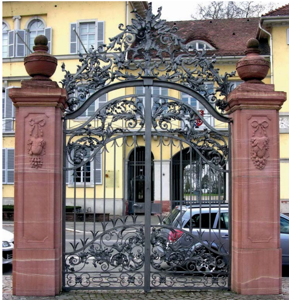
2005 – Schloß Edingen-Neckarhausen Durchgeführte Arbeiten: Reproduktion und Austausch der Torpfeiler mit Ziergirlanden. Reinigung und Restaurierung der Vasen.
