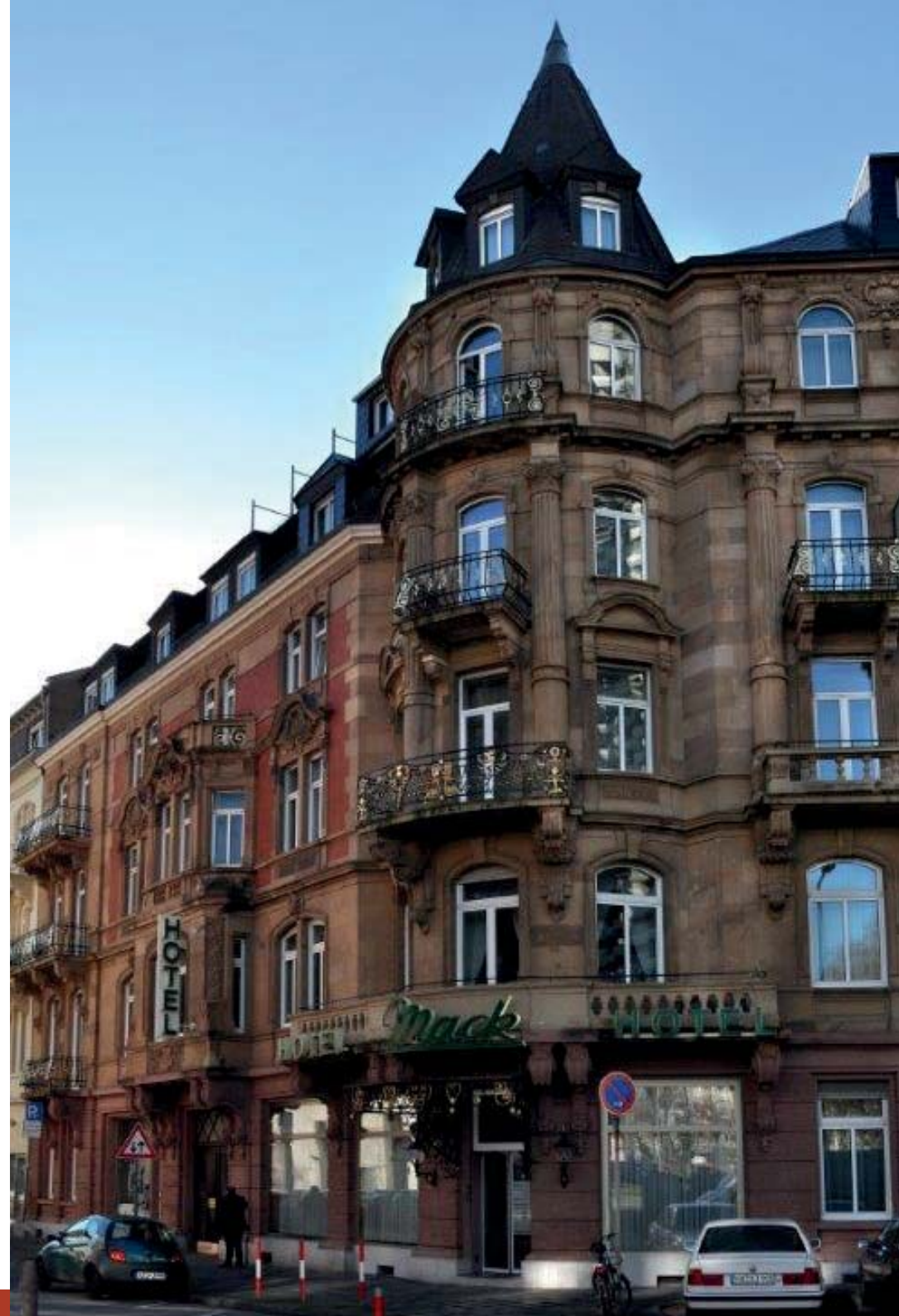
2002 – Hotel Mack, Mozartstraße 14, Mannheim Durchgeführte Arbeiten: Fassadenreinigung; Restaurierungsarbeiten in Verungs- und Mörteltechnik.
